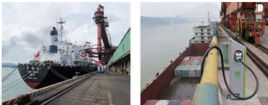
图 21 码头岸电系统
