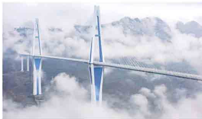
图8 贵州省平塘县平罗高速平塘特大桥
